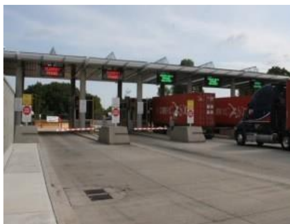
Pont de Queenston - Voies d'inspection primaire (VIP) commerciales
