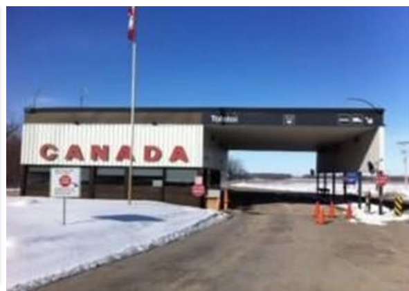
Port d'entrée de Tolstoi
