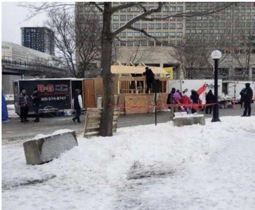
Construction d'une cabane en bois au parc de la Confédération 56
